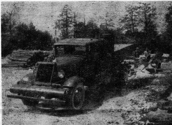
Vana 1,5-tonnise «Fordi» baasil kombineeritud puugaasigeneraatoriga auto oli üks kolmest masinast, millega tuli saarel sõjajärgselt läbi ajada.
